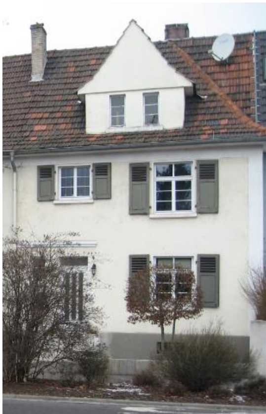
Abb. 10: Foto Metzer Straße 4 als Positivbeispiel
