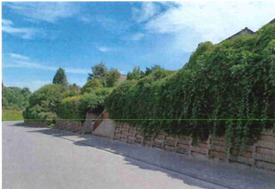
Foto 3: Stützmauer (von der Felsberger Str. aus)
