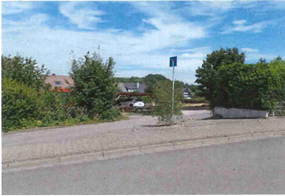
Foto 1: Abzweig Tiergartenstraße / Erschließungsweg
