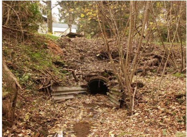
Der Metzerbach wurde oberhalb der Hetschermühle verrohrt und mit dem Erdaushub aus dem Ausbau des ehemaligen Mühlengebäudes überdeckt.
