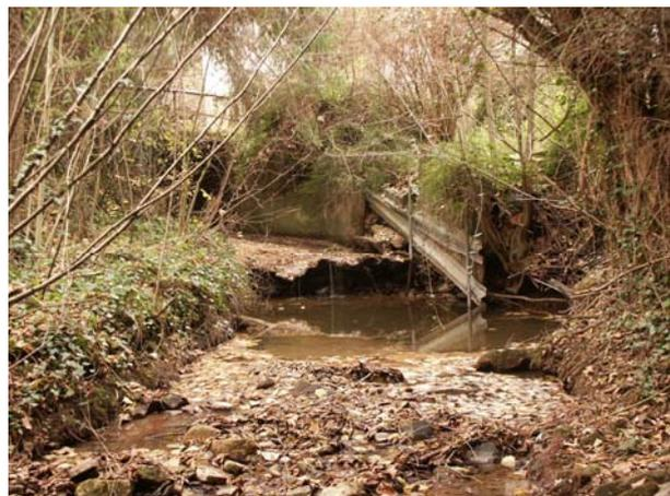
Der Metzerbach wurde unterhalb der Hetschermühle in einer Beton-schulung ausgebaut und mit einer Betonbrücke überbrückt.
