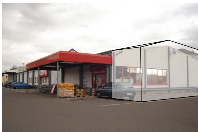
Abbildung 7: Derzeitiges Bestandgebäude des REWE-Marktes mit schemenhafter Erweiterung (eigenes Foto mit eigener Darstellung, ISU 2011)
