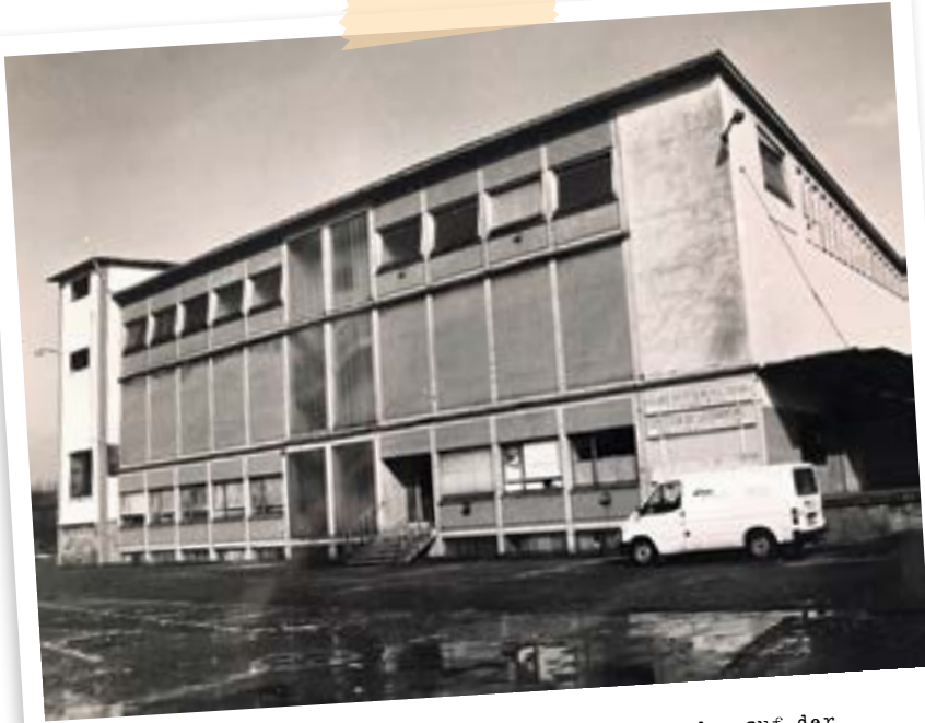
Der Schlachthof war eines der ersten Gebäude, das auf der abgetragenen Festung errichtet wurde. Noch über 20 Jahre, nachdem er seinen Betrieb eingestellt hatte, prägte das Gebäude das Areal auf dem nun der Festungspark Ravelin V entstanden ist. Foto: Pressearchiv der Stadt Saarlouis
