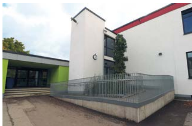
Alle drei Trakte verfügen nun über einen barrierefreien Zugang mit Rampe und Aufzug, wie hier zu sehen zwischen Trakt 2 und Laubengang.
