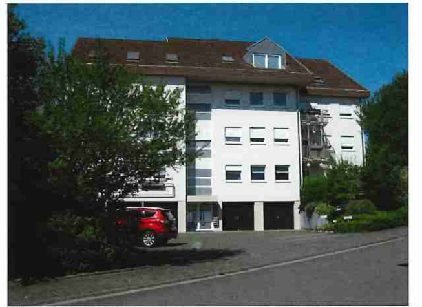
Foto 6: Ansicht des nördl. angrenzenden Mehrfamilienhauses
