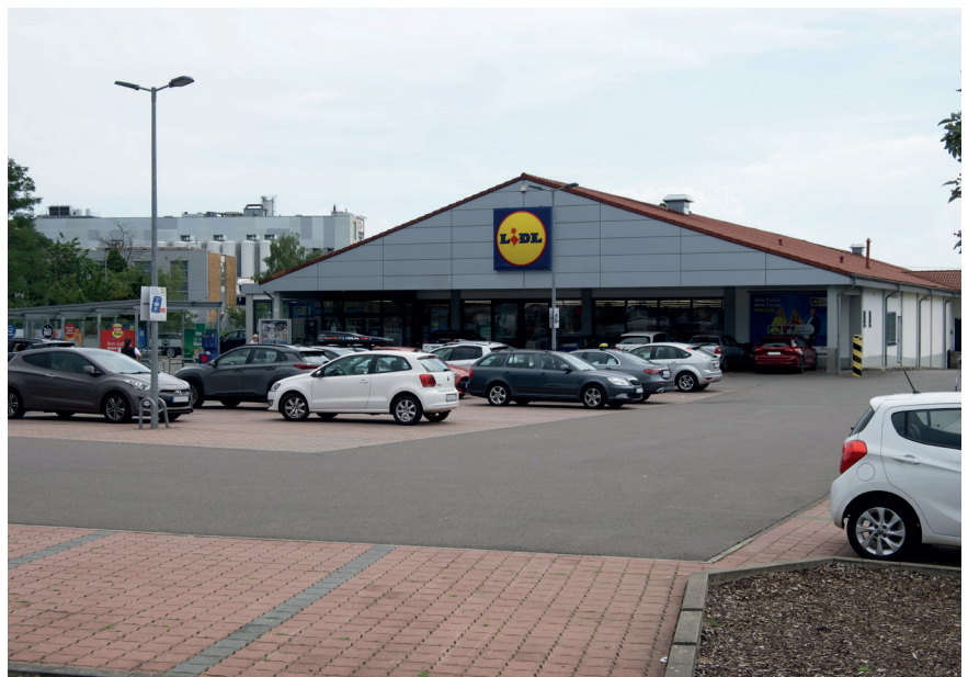
Bestehender Lidl-Markt am Nahversorgungsstandort „Am Kirchenbach“ (Blick aus nördlicher Richtung)
