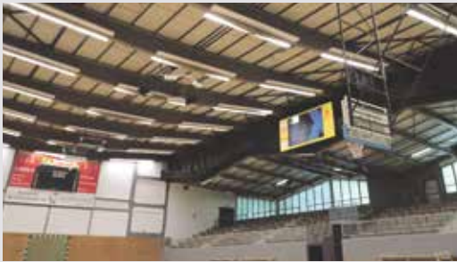
▲ Die Hallenbeleuchtung wurde erneuert und auf LEDs umgestellt. Jetzt ist es möglich, die Leuchtkraft zu reduzieren um somit während dem Training Energie zu sparen. Für die Spiele strahlen die Lampen dann in voller Stärke.
