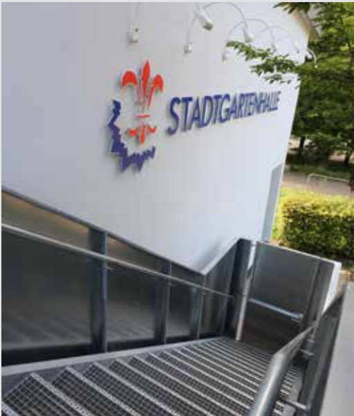
► Über das Clubheim zu erreichen ist die neue Brandschutztreppe, mit der eine neue, zusätzliche Fluchtmöglichkeit für den Ernstfall geschaffen wurde. Nur eine von zahlreichen Brandschutzmaßnahmen, die in der Stadtgartenhalle umgesetzt wurden.
