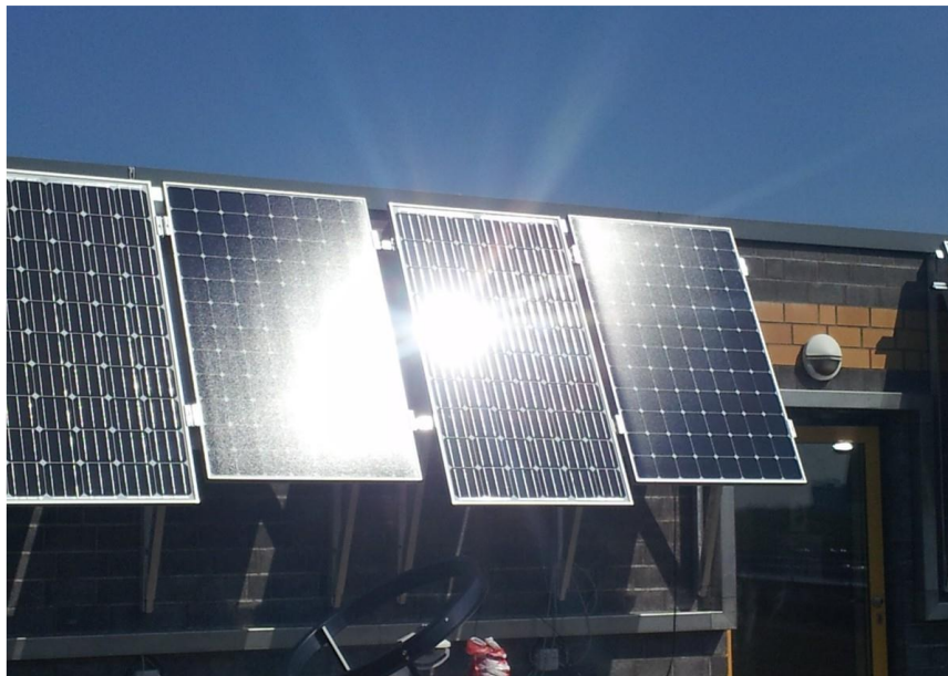
Abbildung 5: Veranschaulichung der Reflexion an einem texturierten Modulglas (mitte-links) und einem glatten Modulglas (mitte-rechts) - Quelle Aufnahme: Fraunhofer-Institut für Solare Energiesysteme ISE
