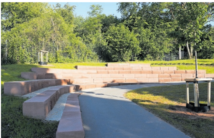
Die neu gestaltete Böschungsfäche an der Grundschule Steinrausch.
