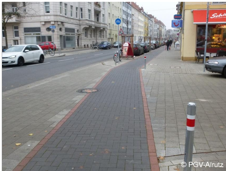
Abb. 5-16: Teilaufpflasterung im Einmündungsbereich einer Nebenstraße (Hannover)
