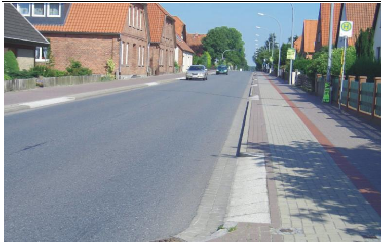
Abb. 5-4: Grundstückszufahrten mit Rampenstein (Soltau)
