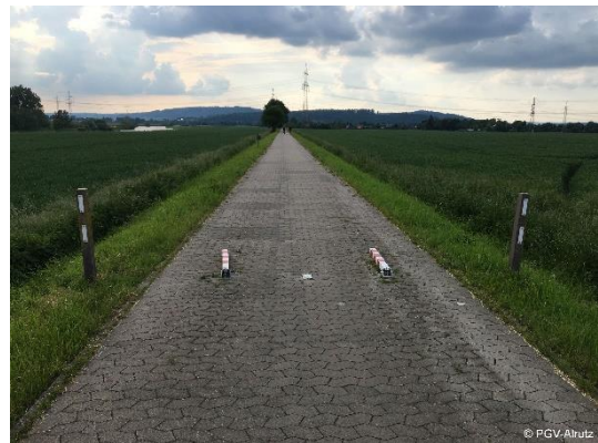
Abb. 5-34: Umklappbare Poller in hoch- und runtergeklapptem Zustand (Weserradweg, bei Hameln)
