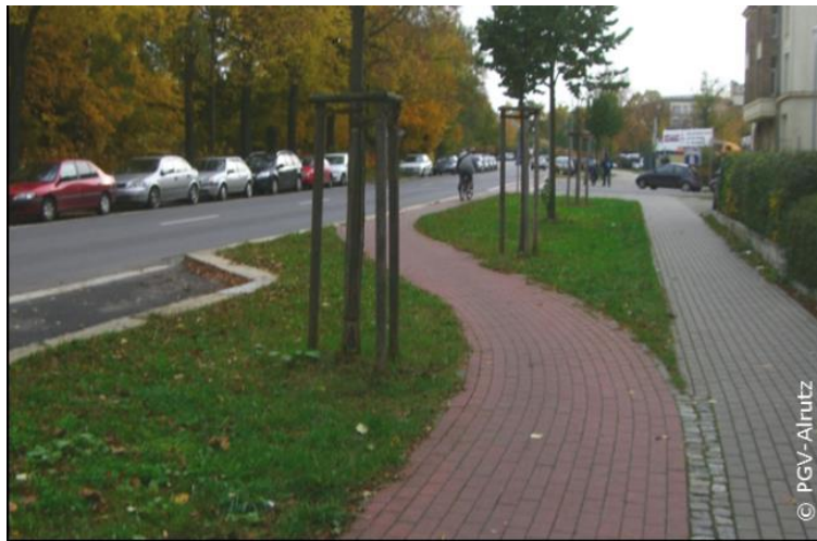
Abb. 5-15: Radverkehr wird im Vorfeld des Knotens an den Fahrbahnrand und damit ins Sichtfeld des Kfz-Verkehrs geführt
