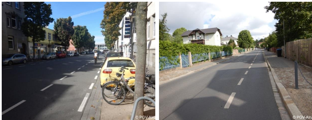
Abb. 5-12: Links: Schutzstreifen mit Sicherheitstrennstreifen zu parkenden Kfz (Hildesheim); rechts: Einseitiger Schutzstreifen (Radebeul, Moritzburger Straße)
