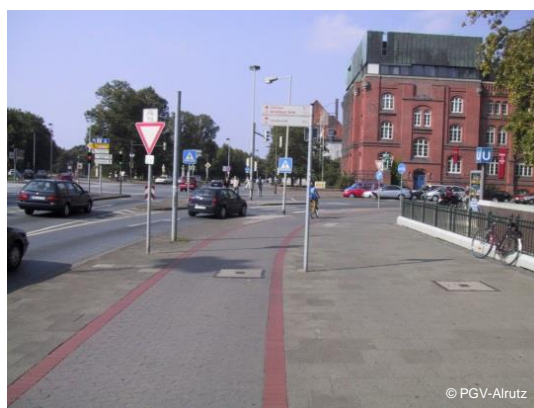
Abb. 5-19: Rückbau und Signalisierung eines konfliktträchtigen freien Rechtsabbiegefahrstreifens in Hannover (links vorher, rechts nachher)
