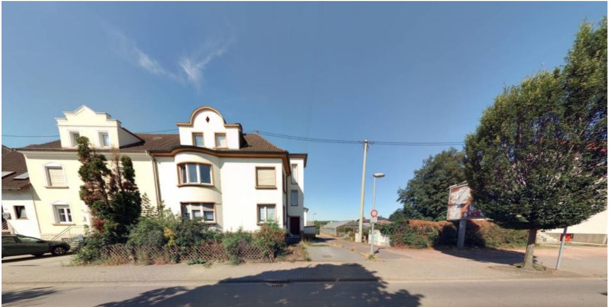
Foto: Provinzialstraße Verbindungsweg und Provinzialstraße 42, 44, 46, 48 und 50, Quelle: Street Smart
