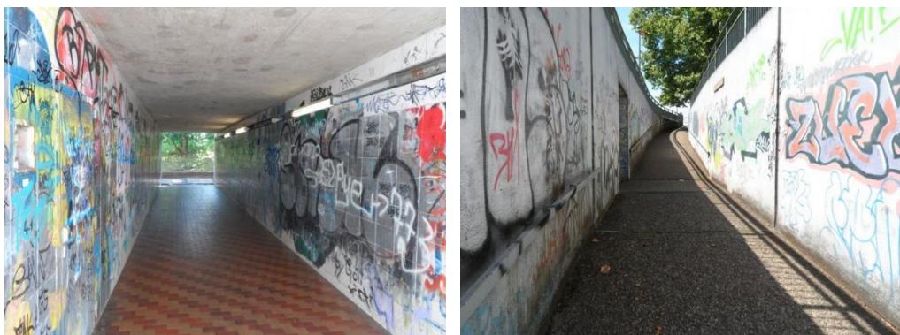
Abb. 19: Unterführungen im Bereich der Bundesstraßen
