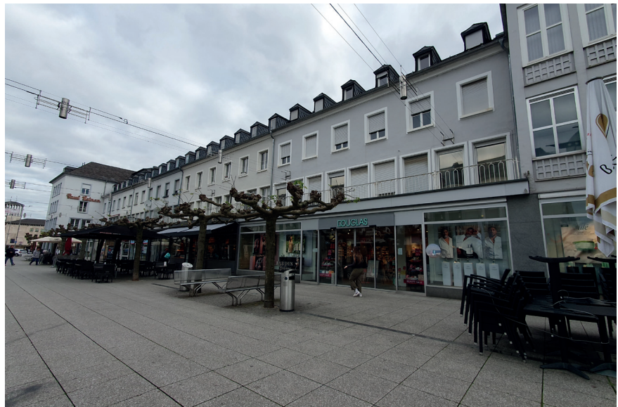
erhaltenswerte Baustrukturen im Bereich der Französischen Straße (Denkmalensemble)
